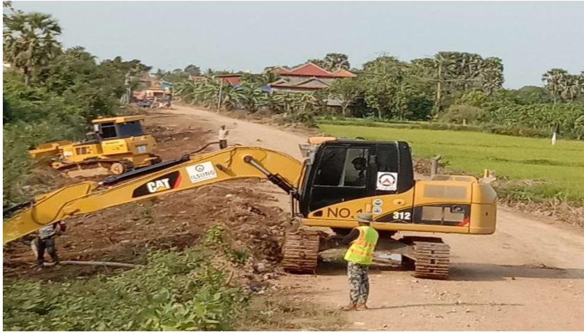
រូបភាពទី 7-សកម្មភាពឈូសឆាយរបស់ក្រុមហ៊ុនដែលបណ្តាលឱ្យប៉ះពាល់ដល់បណ្តាញបំពង់ទឹកស្អាត
